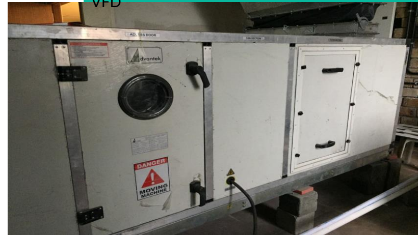
ប្រព្រឹត្តកម្មខ្យល់ស្រស់ដោយមានរបៀបយោសិតកម្មចំនួនពីរ (dual coil)
